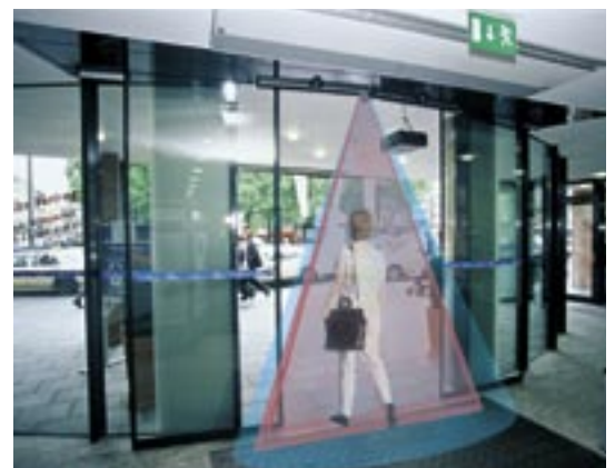
Lóbulos de detección radar (inclinación 27° con antena de lóbulo ancho) Cortina de seguridad (inclinación - 4° con cara anterior lóbulo estrecho) Montaje a 2,20 m - antena de 3 elementos
